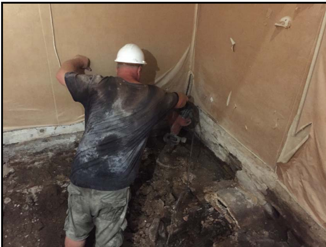
Foto 7: operari destruint el paviment (UE 1) i la seva base (UE 2).
