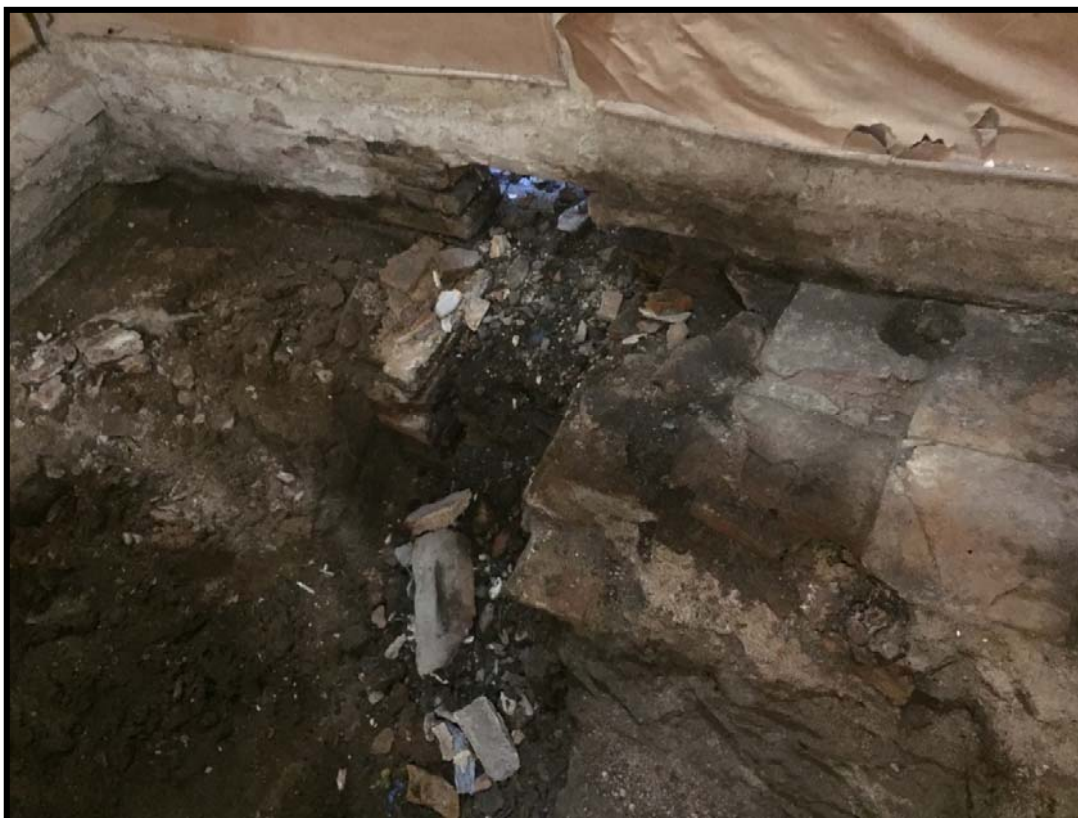
Foto 8: part superior de la claveguera desmuntada. A continuació s'excava el rebliment (UE 14).
