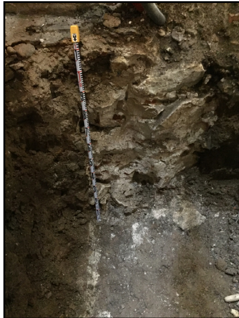
Foto 12: mur de pedra i formigó.
