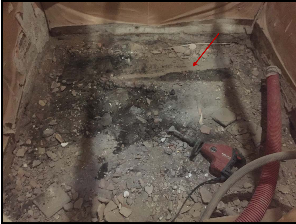
Foto 1: lloc on s'ha de realitzar la fossa. El paviment actual ja havia estat extret, i es podia veure l'antic (UE 1) retallat (UE 2). El retall es trobava farcit per terra de color gris fosc barrejada amb runa moderna i plàstics (UE 7).
