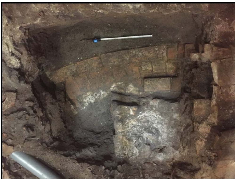
Foto 3: Canal de la claveguera (UE 4) i pilar de pedra i morter (UE 11). A la part dreta de la foto es pot apreciar la coberta de la claveguera. (El metre mesura 0,55m)
